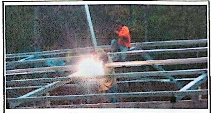
Foto 4: Instalacion de costaneras de las aulas.
