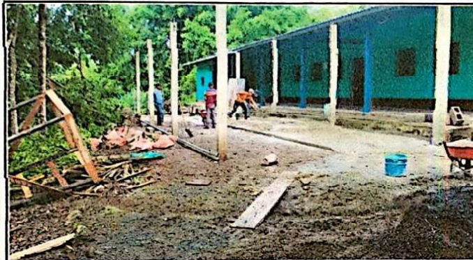
Foto 3: Fundicion de entortado de cemento del exterior del aula.
