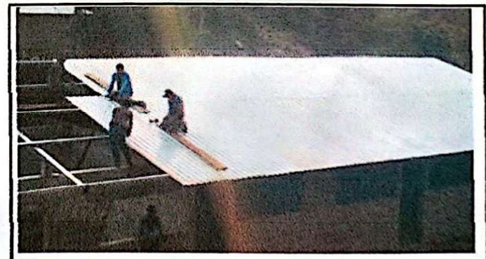
Foto 6: Instalacion de laminas troqueladas de las aulas.
