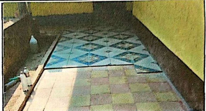
Foto 2: Colocación de Piso en los corredores, aulas modulo 1.
