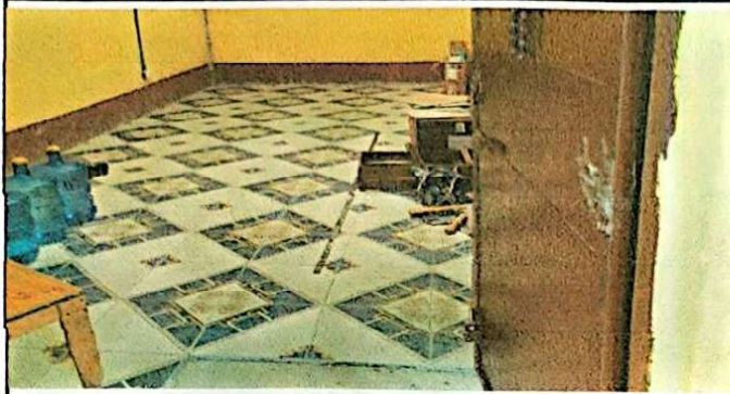
Foto1: instalacion de Piso ceramico dentro de las aulas modulo 1
