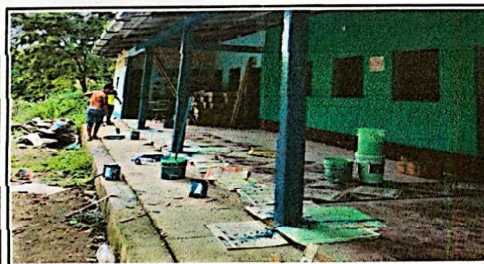
Foto 5: Instalacion de piso cerámico en el corredor de las aulas.
